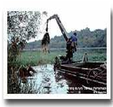
FIG. 4.20 – Arrachage mécanique à l'Etang du Turc
